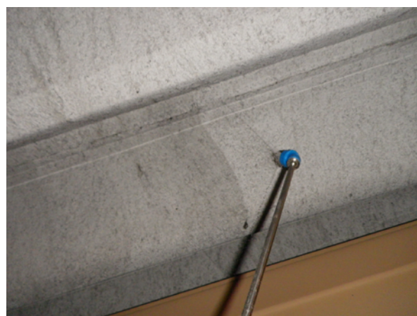
屋根用折半石綿含有断熱材への散布
