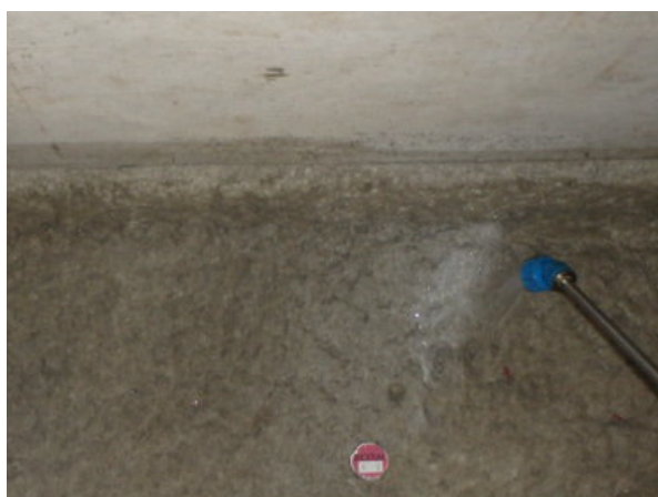
吹き付け石綿への散布
