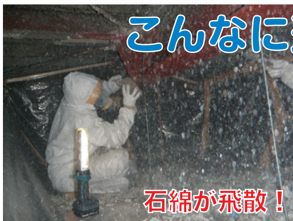
一般的な除去作業の様子
