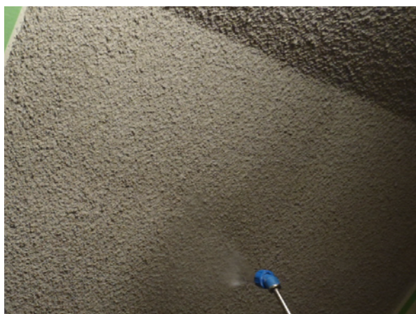
石綿含有ひる石吹き付け材への散布
